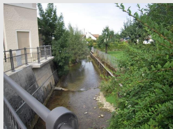
Schulstrasse Blickrichtung Norden
