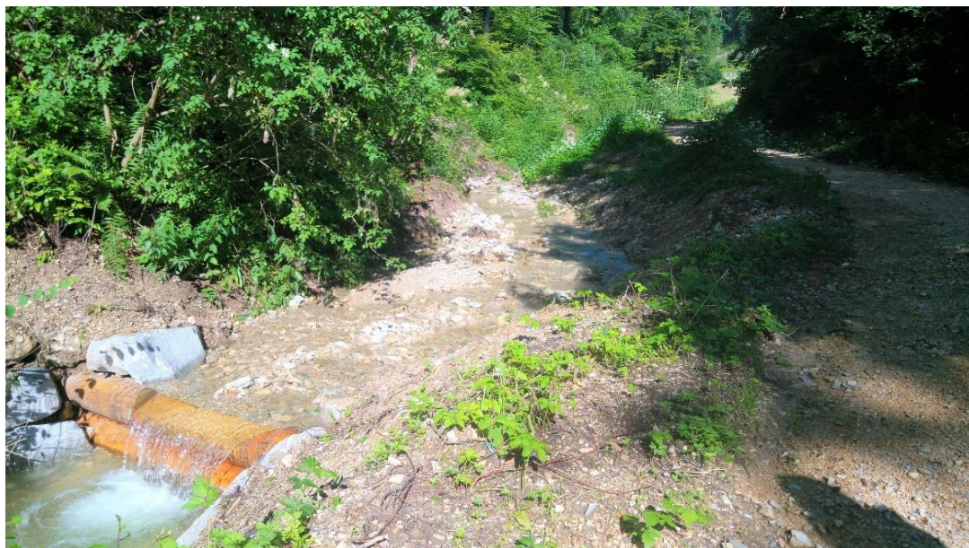
Die neu eingebauten Holzschwellen stabilisieren den Wasserlauf und konnten das Hochwasser ohne Probleme ins Tal leiten
